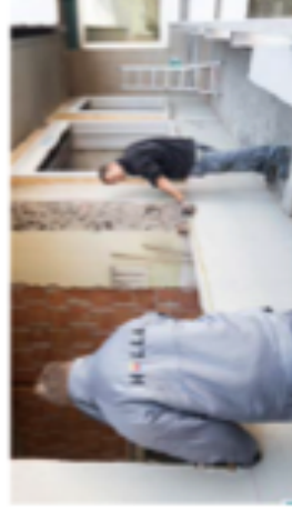
1 MISURARE L'APERTURA DELLA MURATURA
