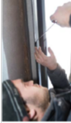
12 APLICARE IL NASTRO ISOLANTE
